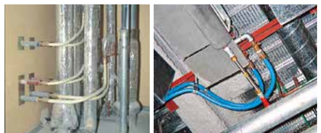
パイプシャフト内ユニットバスへの配管例 ファンコイルユニットへの配管例
