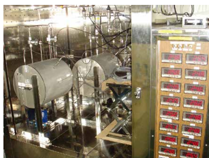
実ガス測定設備
