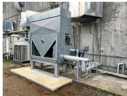
【チルドタワー設置状況】
